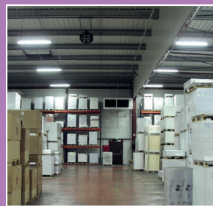
Entrepôts de stockage
